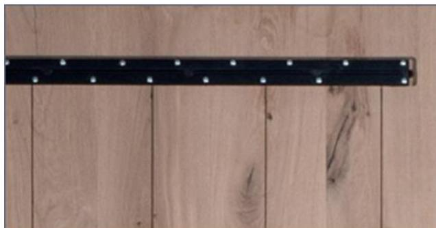
Rückseite mit Stahlprofilen und Entlastungsrillen
