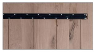
Rückseite mit Stahlprofilen und Entlastungsrillen
